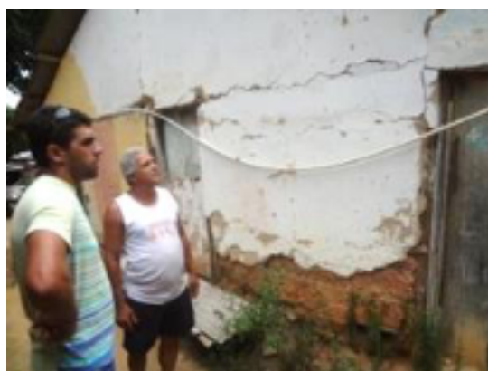
Imagens 11 e 12 - Rachaduras nas casas causadas pela explosão de dinamites
