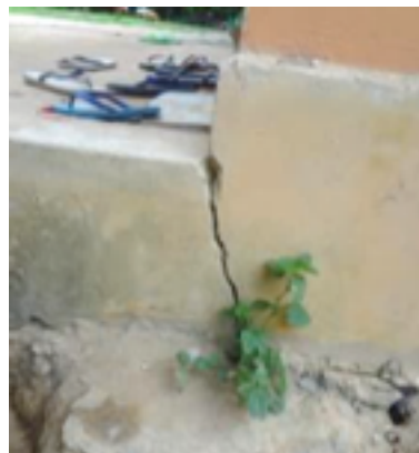
Imagens 11 e 12 - Rachaduras nas casas causadas pela explosão de dinamites
