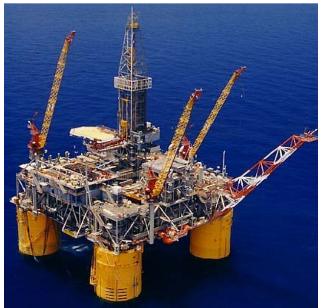
Figura 14. Plataforma tension legs no Golfo do México. Fonte: www.phudpucker.com
