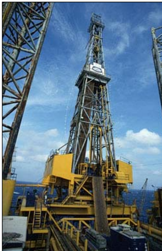
Figura 6. Sonda de perfuração usada em área offshore .
